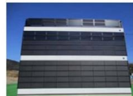
ビル壁面等に太陽光パネルを設置した例
