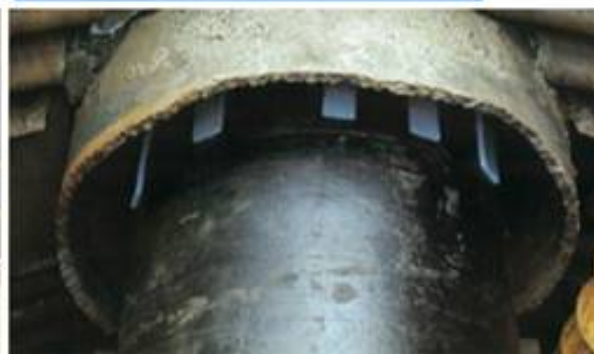
内管挿入工法(PIP工法)
